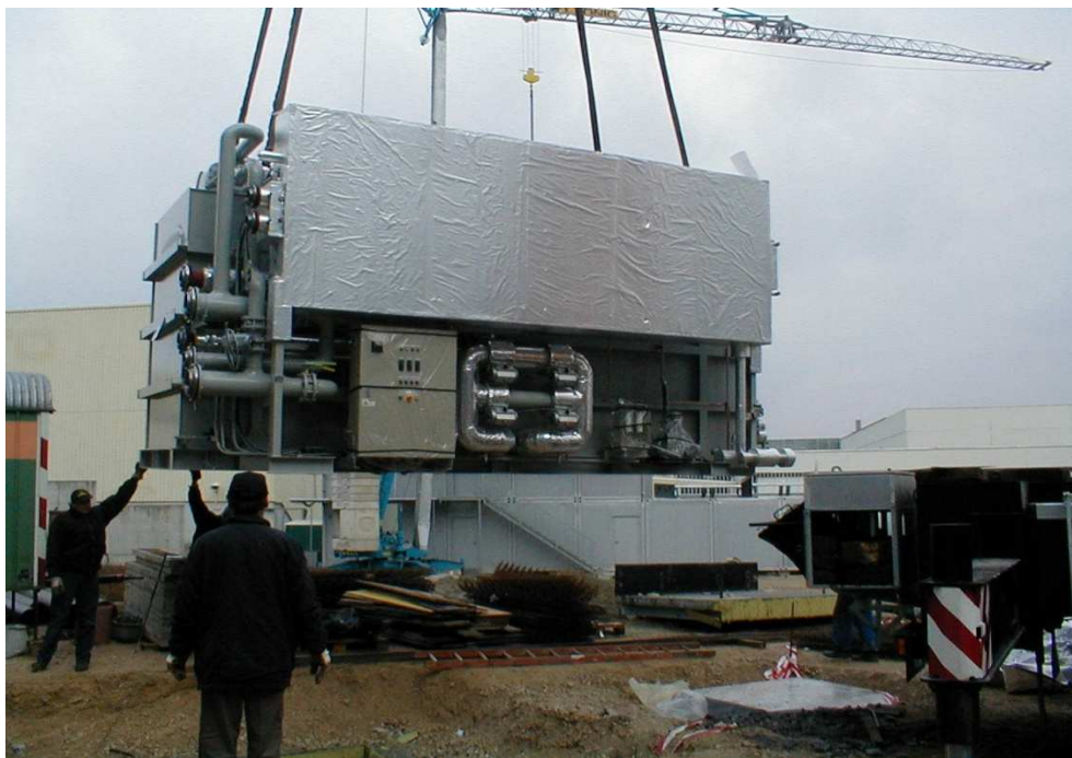
Figur 9.1 Eksempel på en fjernvarmedrevet varmepumpe (adsorptionsmaskine, MYCOM ADR-100) til 1MW i varme output. Princippet med en varmedrevet varmepumpe på fjernvarme er anvendt i Danmark i mindre skala til Green Light House og Viborg Rådhus. Som nævnt i anbefalingerne bør en sådan løsning undersøges nærmere til den CO 2 -neutrale bydel
